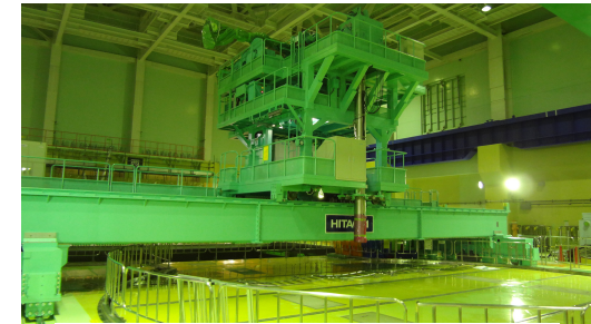
燃料取替機耐震強化工事
