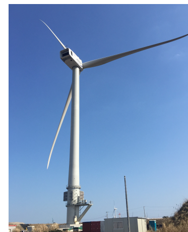
鹿島港深芝風力発電所 (5MW機)
